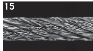
15 Dieses Drahtseil wurde über die Flanke einer Seilscheibe gezogen. Beachten Sie die geneigte Schadensspur.
