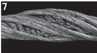
7 Die durch Verdrehung des Seils erzeugte Überlänge der Litzen in der Stahleinlage wurde von einer Seilscheibe zu einem Punkt hin massiert. Derartige Schäden finden sich oft am Endpunkt der Seilbewegung über Scheibe oder Trommel.
