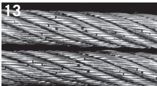
13 Ermüdungsbrüche auf Stahlseilen mit verdichteten Außenlitzen.
